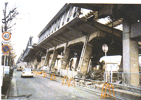
阪神大震災による鉄道施設被災（国土交通省ホームページより）
