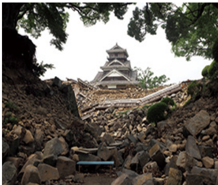
被害を受けた熊本城（内閣府防災情報ホームページより）
