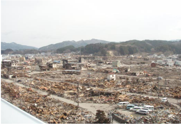
東日本大震災の津波による被害（内閣府災情報ホームページより）
